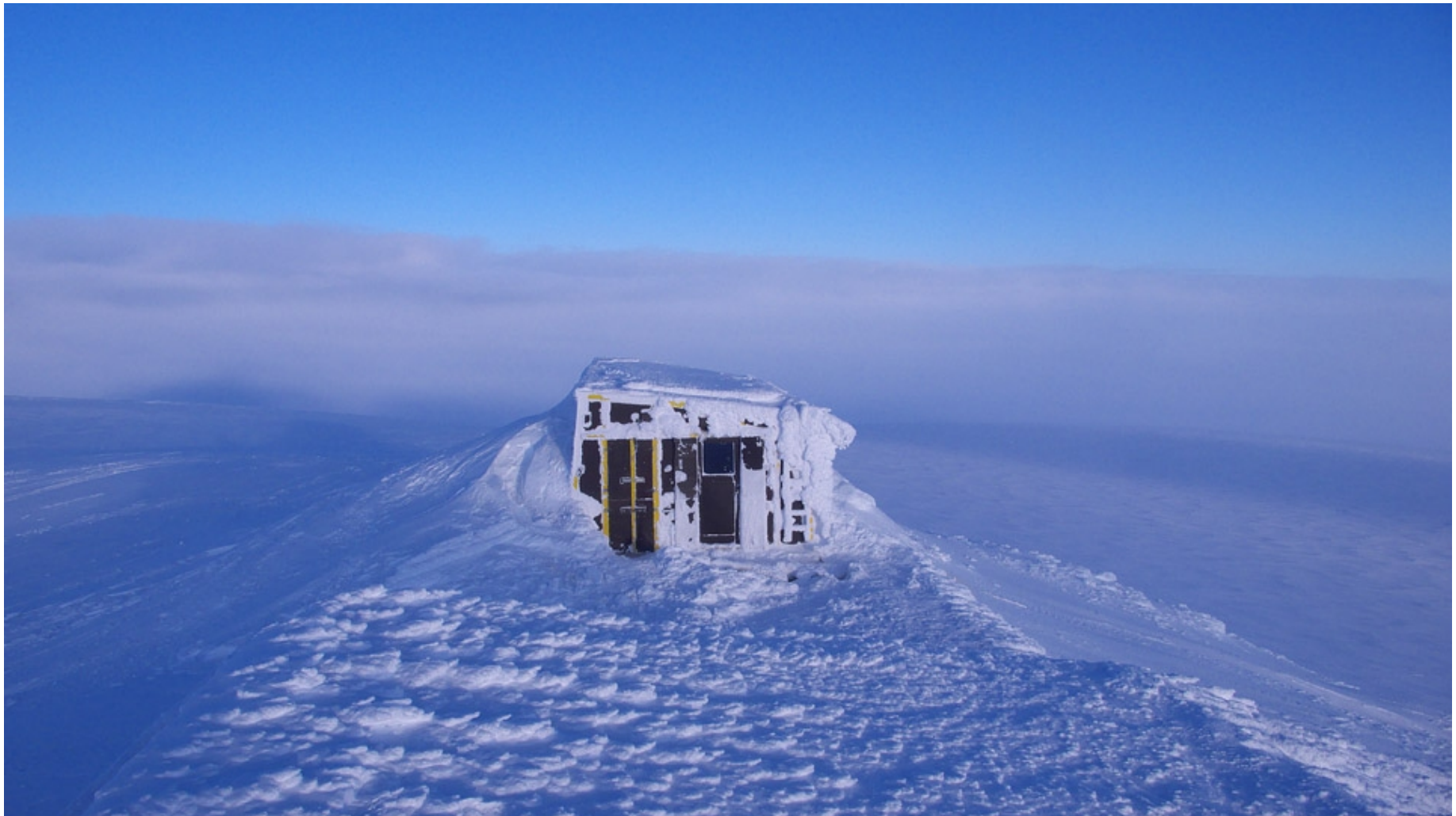
Les glaciologues Islandais ont bâti un refuge sur la lèvre orientale du volcan Grimsfjall, le plus actif du pays. Situé sur un pointement rocheux qui domine de 200 m la calotte alentour, 'il s'agit d'un des endroits les plus ventés d'Islande.
